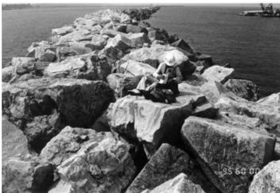
Figura 4-72 Ejemplo de enrocado colocado de forma aleatoria (Figure VI-4-2 del Coastal Engineering Manual).
